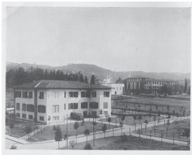
Fig. 2. La palazzina della Farmacia nel 1934, vista dal lato sud.
